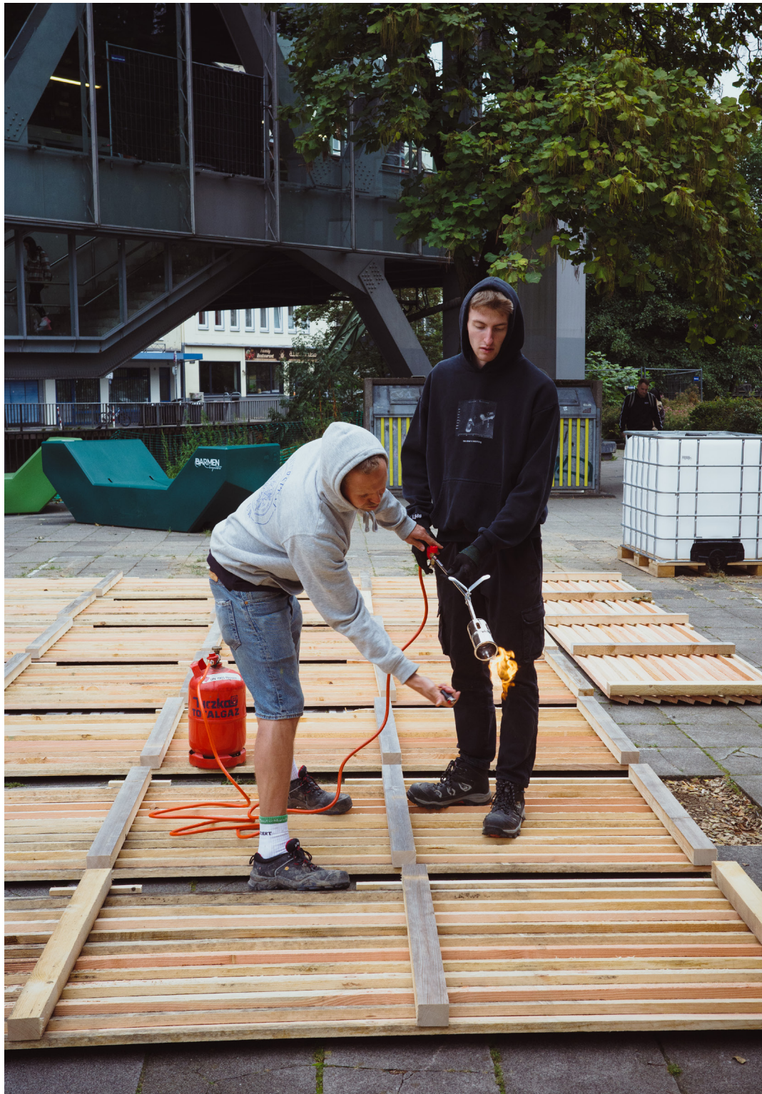
Bretter der Pflanzbeete werden gebläut um sie vor Feuchtigkeit zu schützen
